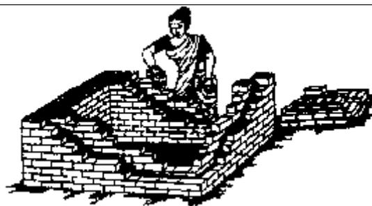
3. Faça uma parede dupla com 70 cm de altura, deixando uma cavidade de 7.5 cm de largura entre as duas paredes.
