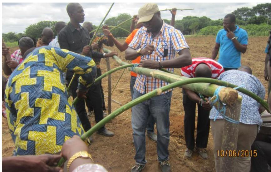
**Figure 8** : Construction d'un tunnel de multiplication rapide de boutures de patate douce
